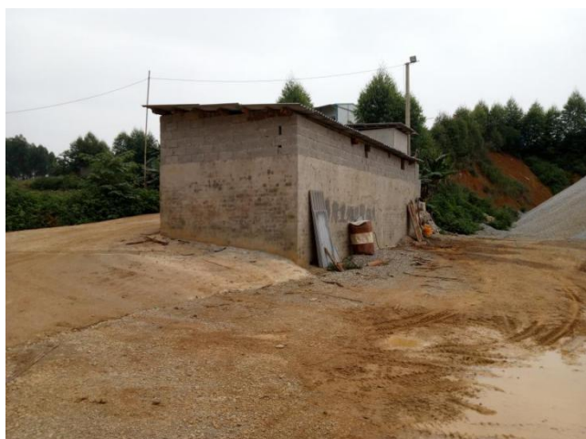
柴油储罐房及围堰
