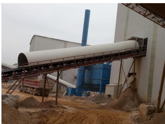
输送带半封闭措施
