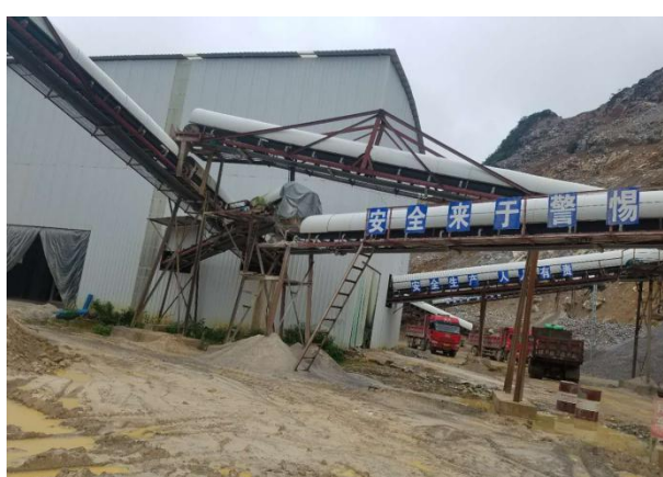
输送带接口全封闭措施
