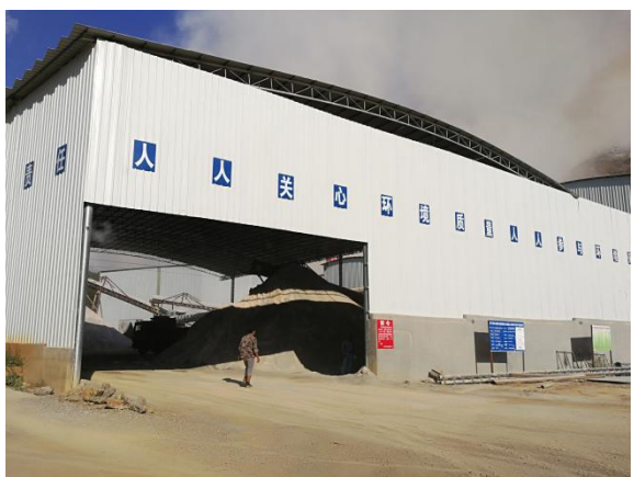
石粉堆场半封闭措施
