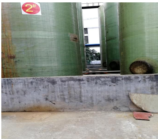
储罐围堰
