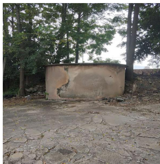
地下水监测井
