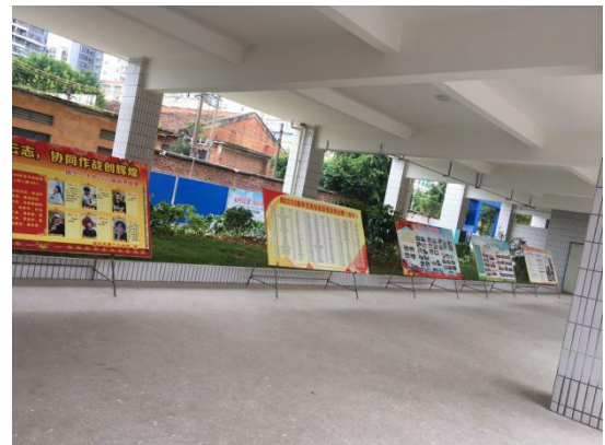
实验楼 1 楼架空层
