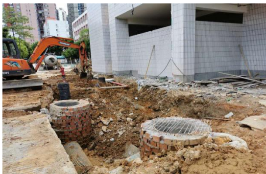
施工期化粪池
