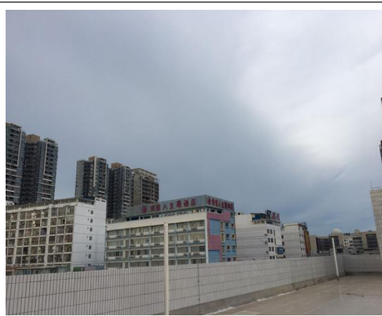
项目北面现状
