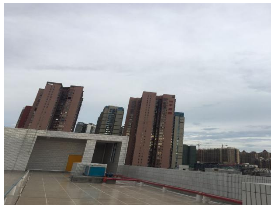
项目东面现状
