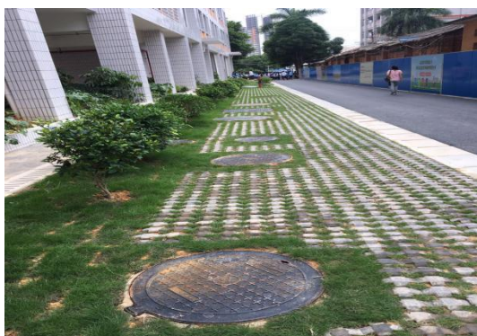
运营期化粪池及酸碱中和池
