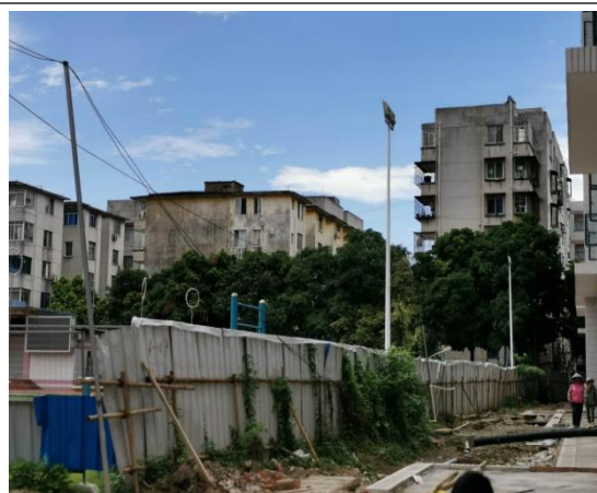
项目西面现状
